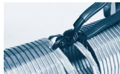
Schritt 3: Überstehendes Profil mit Bleischere oder Zange abschneiden.
